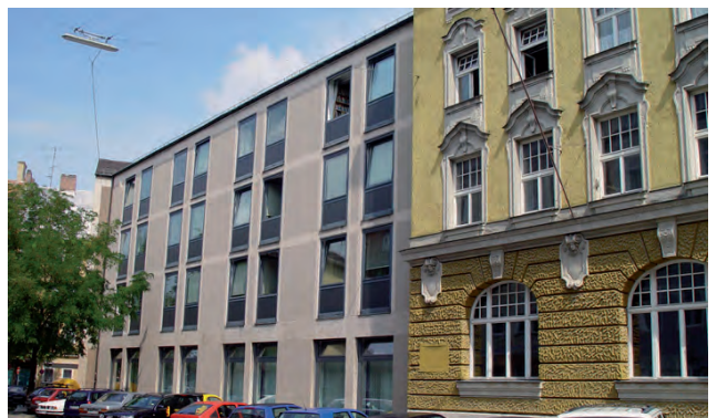
Abbildung 4: Das Dienstgebäude Pfarrstraße München
