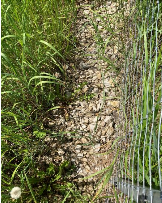
Bild 17: Lösung 1, eingegrabener Zaun hier mit Geröll verfüllt bzw. eingegraben
