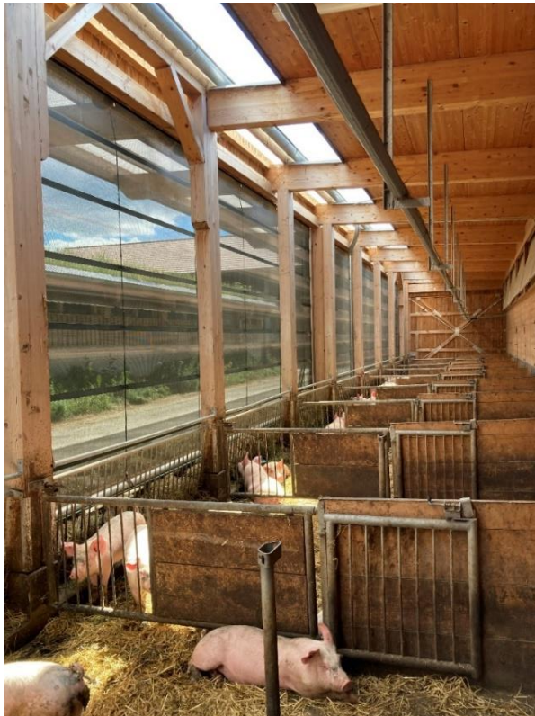
Bild 4: Maststall seitlich durch Windschutznetz weitgehend geschützt. Offene Bereiche im Dach als eine Forderung der EU-Öko-Verordnung (max. 75 % Überdachung des Auslaufs im Mastbereich erlaubt)
