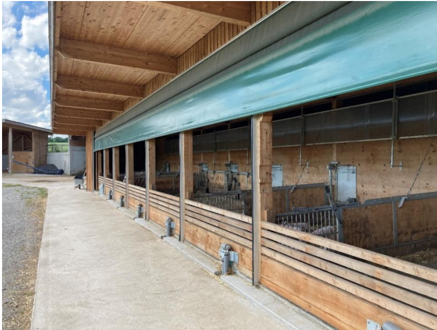
Bild 1: Stall für ferkelführende Sauen mit angebrachten Windschutznetz in offener Stellung
