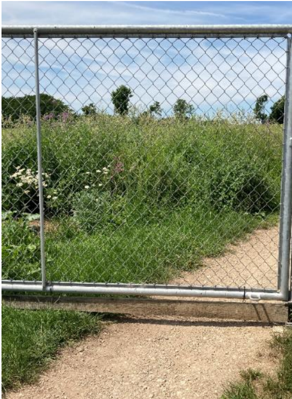
Bild 16: Durch das zusätzlich montierte Brett an der unteren Torkante wird der Abstand zwischen Unterkante, Tor und Boden zur Verhinderung des Eindringens kleiner Wildtiere verkleinert bzw. verhindert
