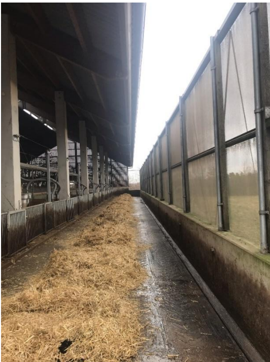
Bild 25: Seitlich fest installiertes Sonnen- und Windschutznetz bestehend aus einer Konstruktion aus in die Betonmauer verankerten Stahlrohren und Holz
