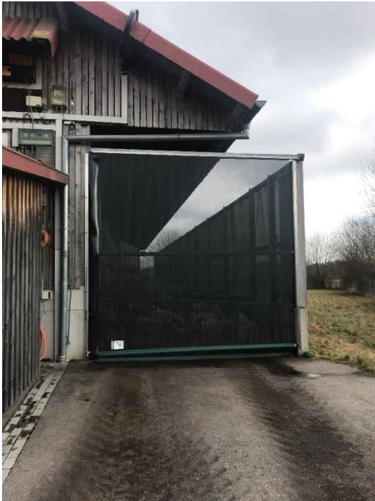
Bild 24: An der Frontseite kann der Windschutz flexibel geöffnet werden, was die Einfahrt zur Entnahme des Mists ermöglicht. Die offenen Bereiche seitlich und im Dachbereich können ergänzend mit einem Vogelnetz ausgestattet werden
