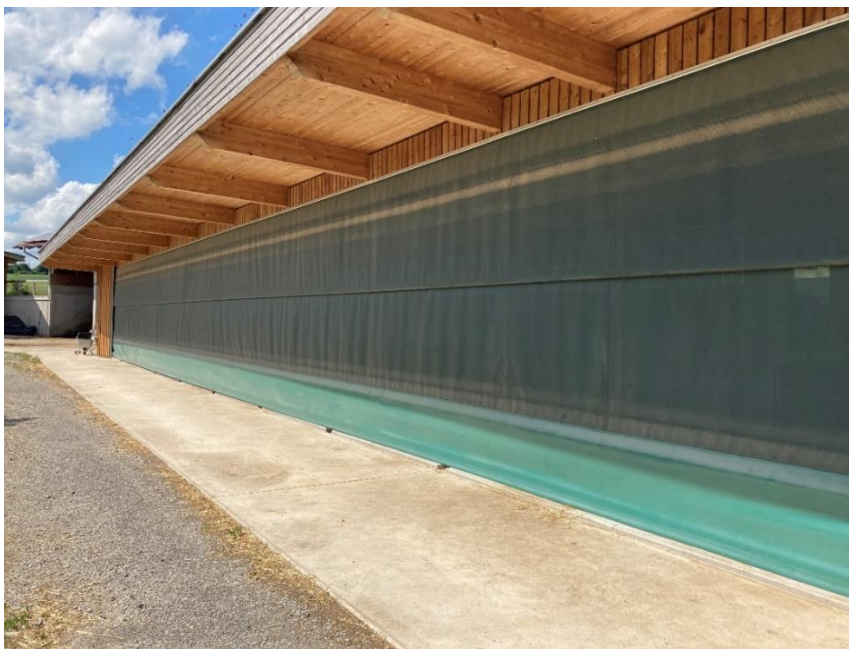
Bild 2: Stall für ferkelführende Sauen mit angebrachten sichtbaren Windschutznetz in geschlossenen Zustand
