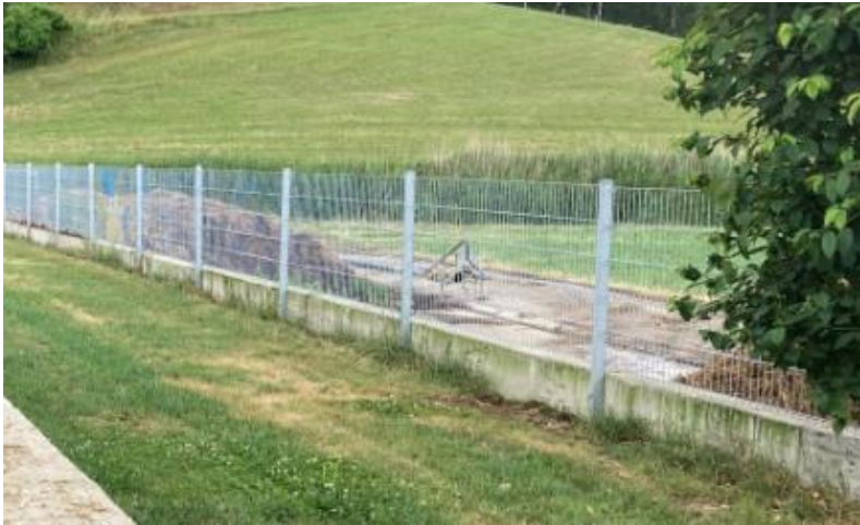
Bild 19: Lösung 3, Unterwühlenschutz mit Hilfe einer im Boden festverankerten niedrigen Betonmauer und einem daran befestigten Doppelstabzaun
