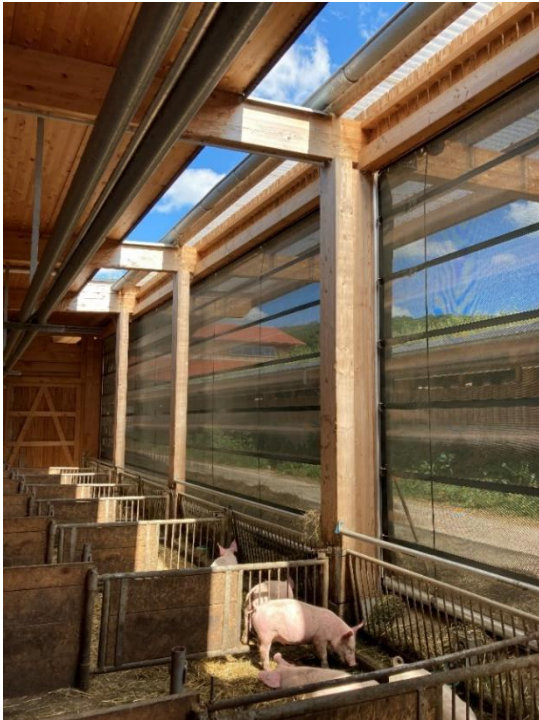
Bild 23: Flexibel auf und abfahrbarer Sonnen- und Windschutz, der gleichzeitig zur seitlichen Abschirmung und Verhinderung des Eindringens von Vögeln dient. Der offene Bereich im Dach bei bestehender Teilüberdachung kann weiterhin mit einem Vogelnetz überspannt werden
