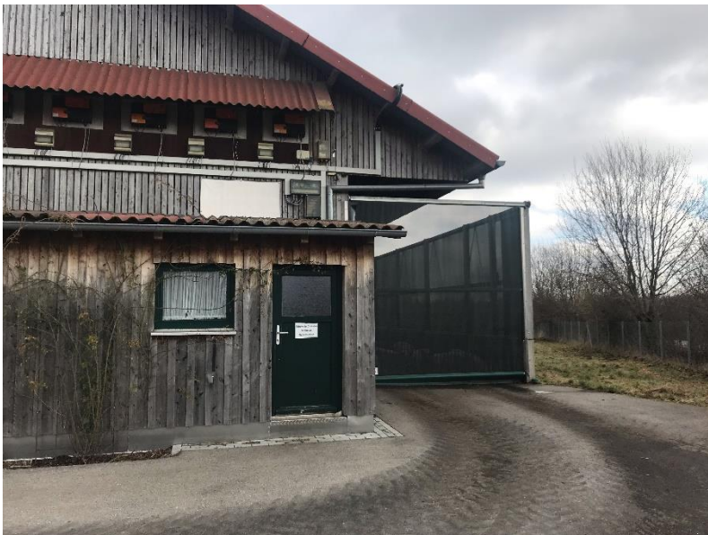
Bild 5: Maststall mit Auslauf im „Pigport“-System mit seitlich angebrachten Windschutznetzen
