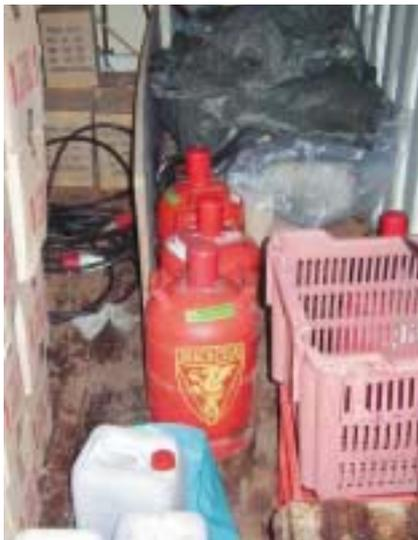
Bild 1: Vorschriftswidrige Lagerung von Druckgasbehältern in einem Container
