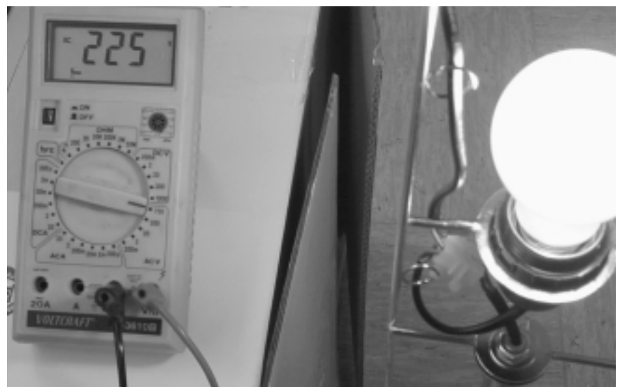
Abb. 16 Lüsterklemme steht durch fehlerhafte Befestigung unter Strom
